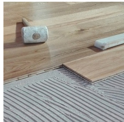
Incollaggio di pavimento in legno su pavimento esistente
