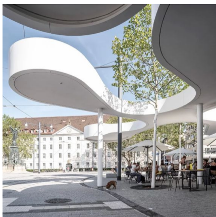
Fermata del bus abbinata a bar e ristorante a Friburgo (DE)
