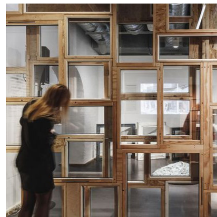
Parete trasparente realizzata con serramenti dismessi
