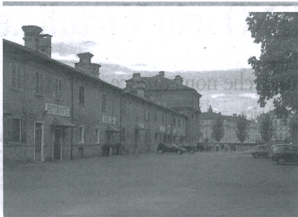
Il bando prevede quattro ambiti progettuali: Stupinigi, la ferrovia, l'ex Viberti e il torrente Sangone
