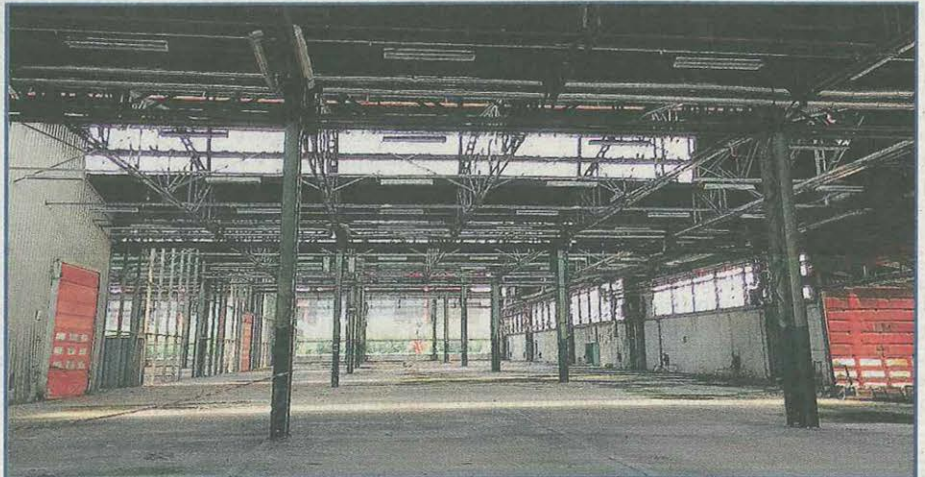
Una parte del capannone che ospitava il polo logistico della Fiat in corso Settembrini
